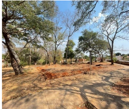
Prefeitura inicia as obras do playground infantil com 6 torres e grama artificial na Pista de Cooper.
