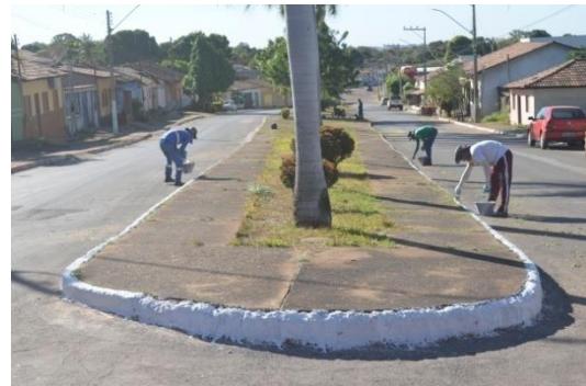
Prefeitura realiza pintura de meio fio.
