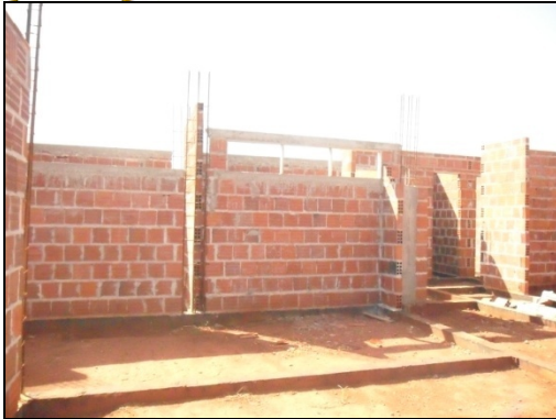
Imagem 03: Paredes ainda não concluídas podem
