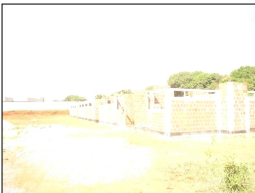
Imagem 07: Paredes do bloco de serviço e salas I e II, com duas fiadas acima da verga de portas e janelas à exceção de algumas a serem construídas.
