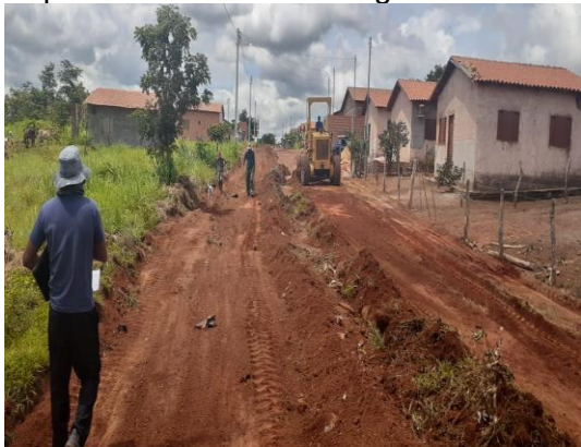
Início das obras do asfalto com recursos de emenda parlamentar do Deputado Carlos Gaguim, beneficiara várias ruas da nossa cidade.
