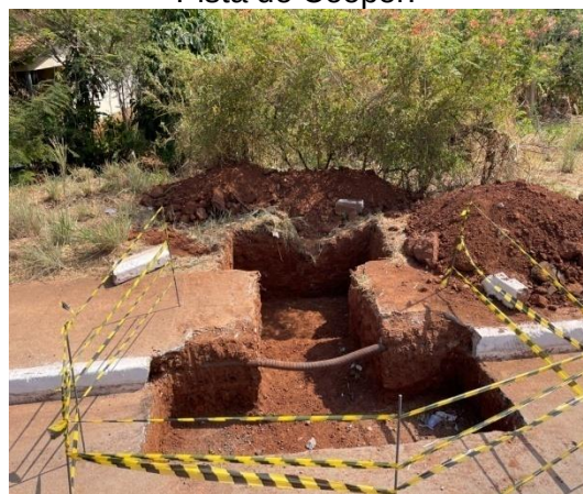
Iniciadas as obras da boca de lobo para escoamento de águas fluviais na Avenida Tocantins.
