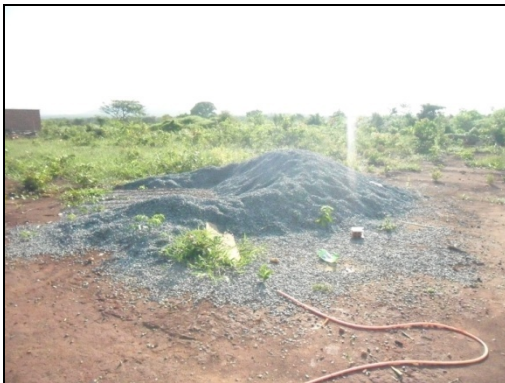
Imagem 11: Agregado graúdo estocado e sem uso a muito tempo.
