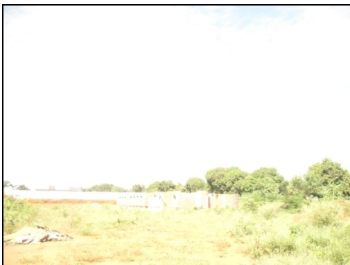
Imagem 05: Vista panorâmica da obra já Com muita vegetação no canteiro.
