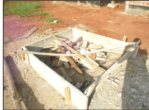
Imagem 10: Local de produção de concreto e argamassa cheio de entulho.
