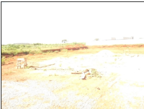
Imagem 01: Material depositado no canteiro de obras.
