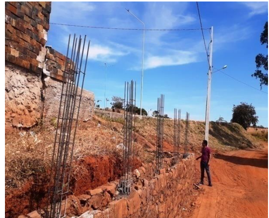
Construção do muro de contenção no portal da cidade. Projeto contempla drenagem de águas fluviais e pavimentação em bloquetes da rua.
