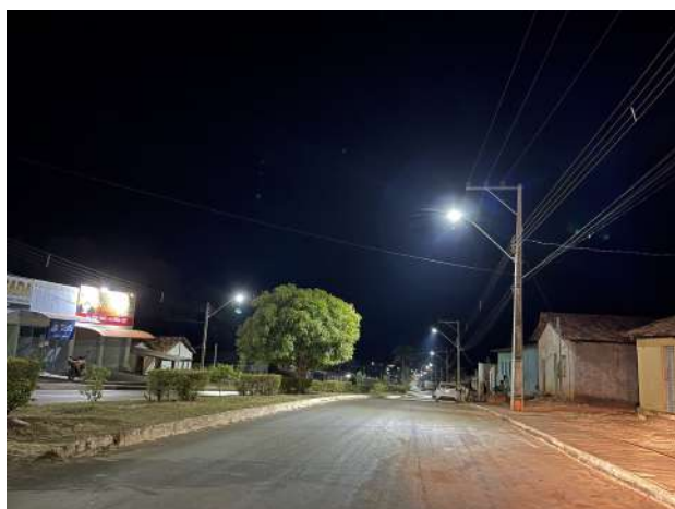
Avenida Elifas Alves Bandeira;
