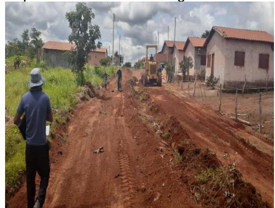
Início das obras do asfalto com recursos de emenda parlamentar do Deputado Carlos Gaguim, beneficiaria várias ruas da nossa cidade.
