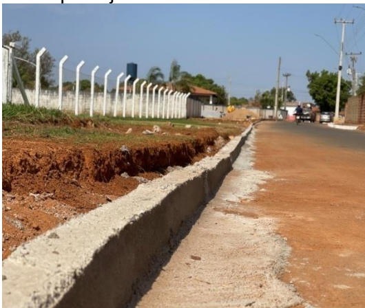
Secretaria de Desenvolvimento Urbano faz reparos em meio fio em vias urbanas da cidade.
