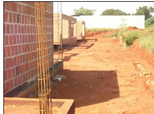
**Imagem 04:** Armadura não concretada Exposta a agentes do ambiente que provocar a sua corrosão.
