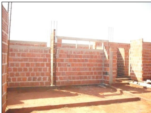
Imagem 03: Paredes ainda não concluídas que podem
